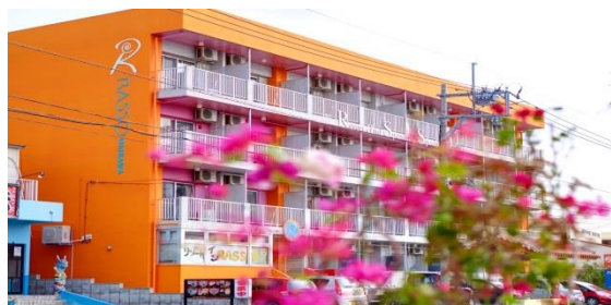
リゾートインラッソ石垣
